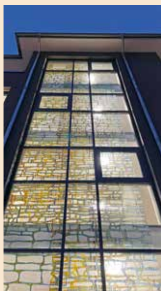
Das gläserne Treppenhaus des Gebäudes erstreckt sich über drei Stockwerke und hat eine Fläche von rund 36 Quadratmetern.
