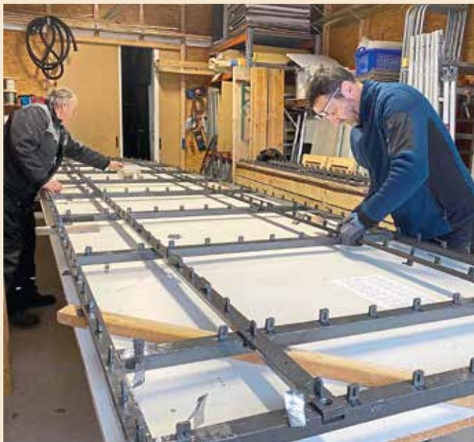
*Auch der Metallrahmen wurde ausgebaut, gereinigt und wiederaufgearbeitet. Mit einem neuen Lacksystem ist er nun wieder gut für die nächsten Jahrzehnte geschützt.*
