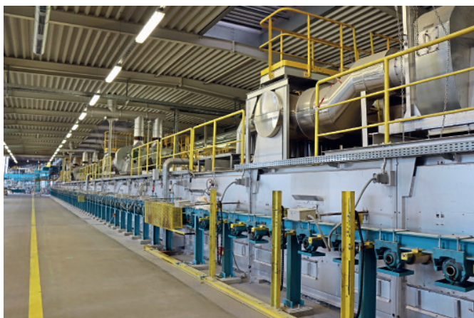
Die Dimensionen des AGC-Werks in Osterweddingen sind riesig: Die Produktionshalle ist ganze 800 Meter lang.
