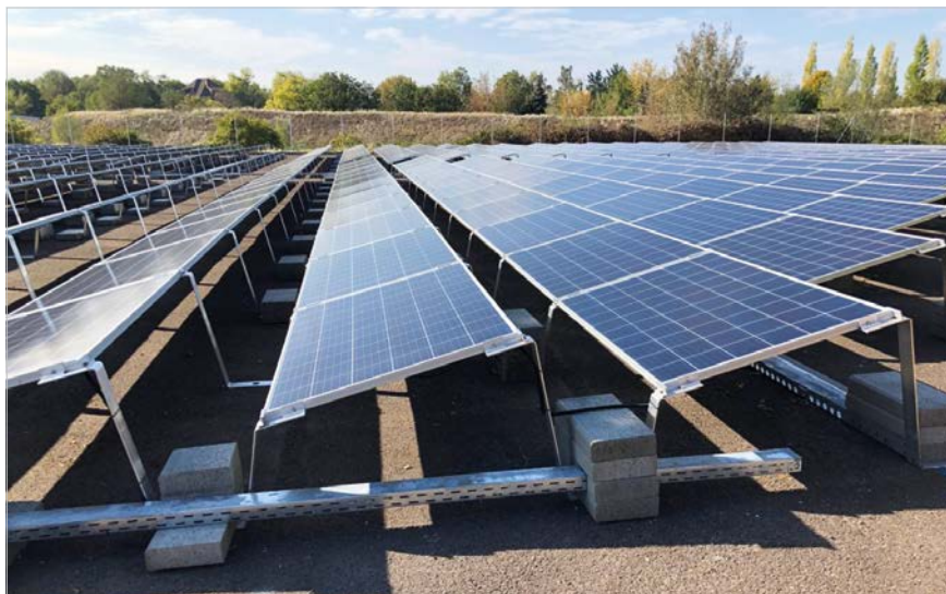
Bei der Gartensolaranlage von IBG Solar werden die Module auf einem aerodynamischen Freilandgestell montiert. Auf diese Weise lassen sie sich auf ganz unterschiedlichen Untergründen installieren.
