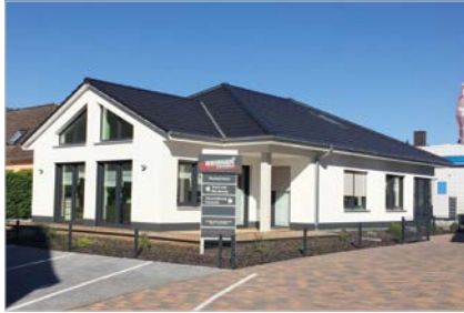
Foto: Beißner Hochbau
