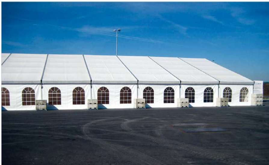
Zulässige Ballastierungen sind in der DIN 13782 beschrieben.
